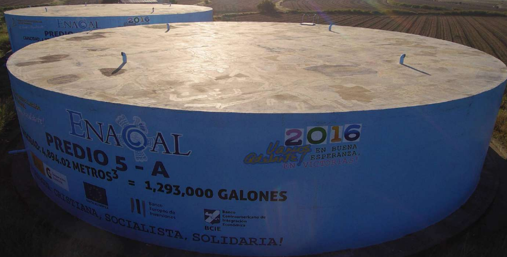
Sistema de Agua Chinandega
