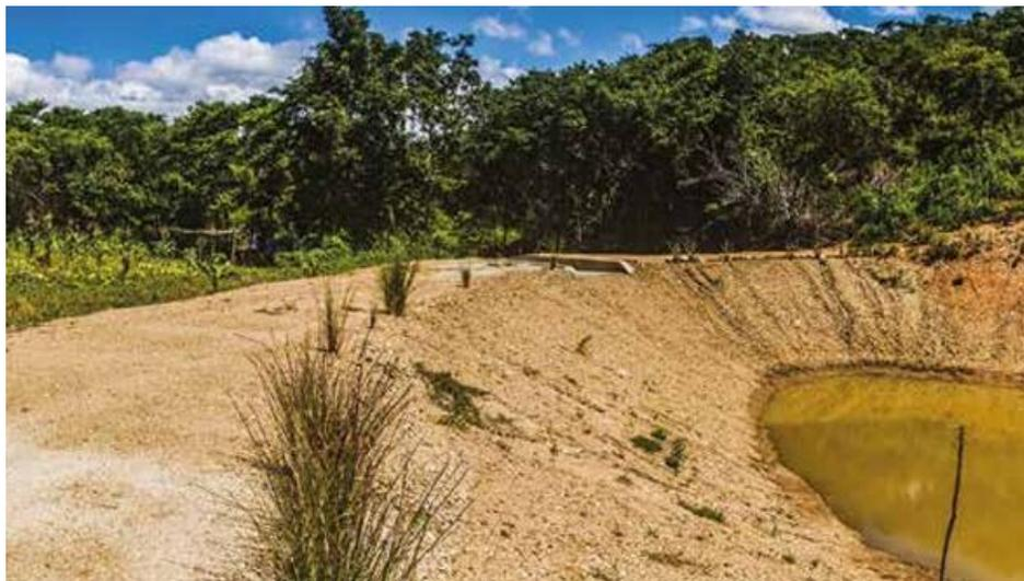
El lodo arcilloso debe usarse con frecuencia para curar fisuras en los taludes internos del reservorio.
