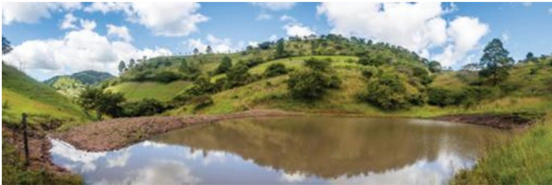
Si en la finca no hay un sitio encajonado, elija un lugar donde no deba excavar mucho para formar el dique en la parte baja. Estas obras se conocen como semi excavadas.
